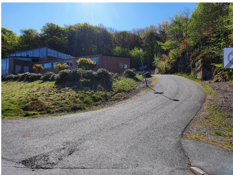
Figur 5. Östra området: Panncentralen och övriga byggnader på fastigheten Backa 866:831 och 866:847. Foto: Tyréns
